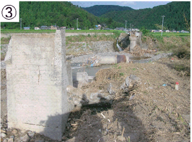
③ 大久保～市波の鉄橋：橋脚で掃流物が堰きとめられ、側面へ越流。橋梁基部が侵食された。後に鉄橋も流出した。
