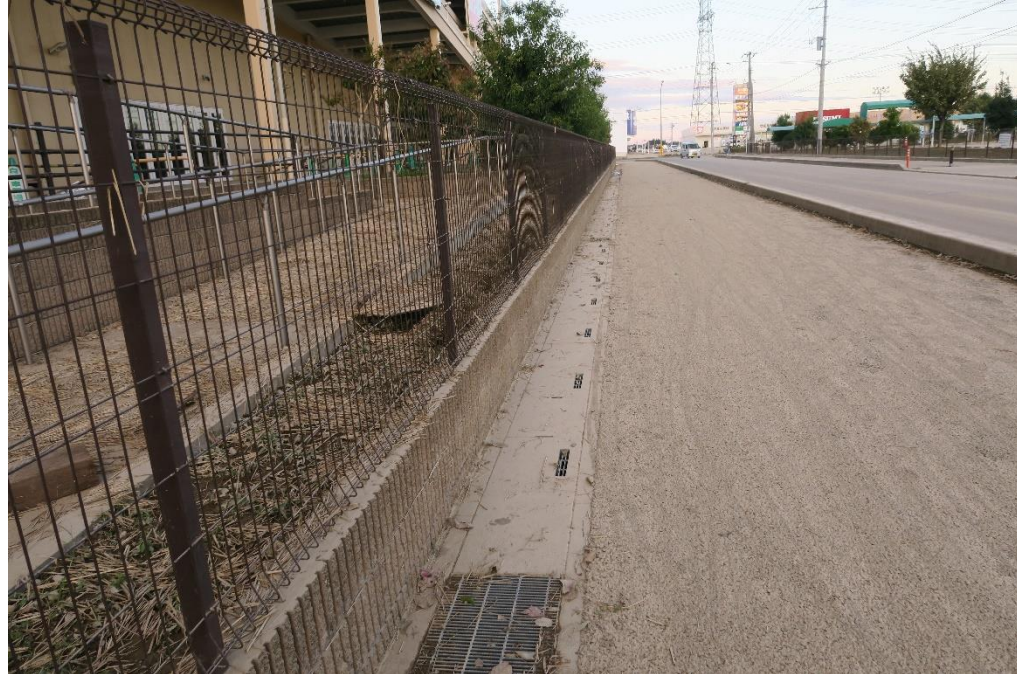
地点⑰(10月13日16時50分撮影) 盛土造成地大型商業施設南側(東松山市あずま町)。
