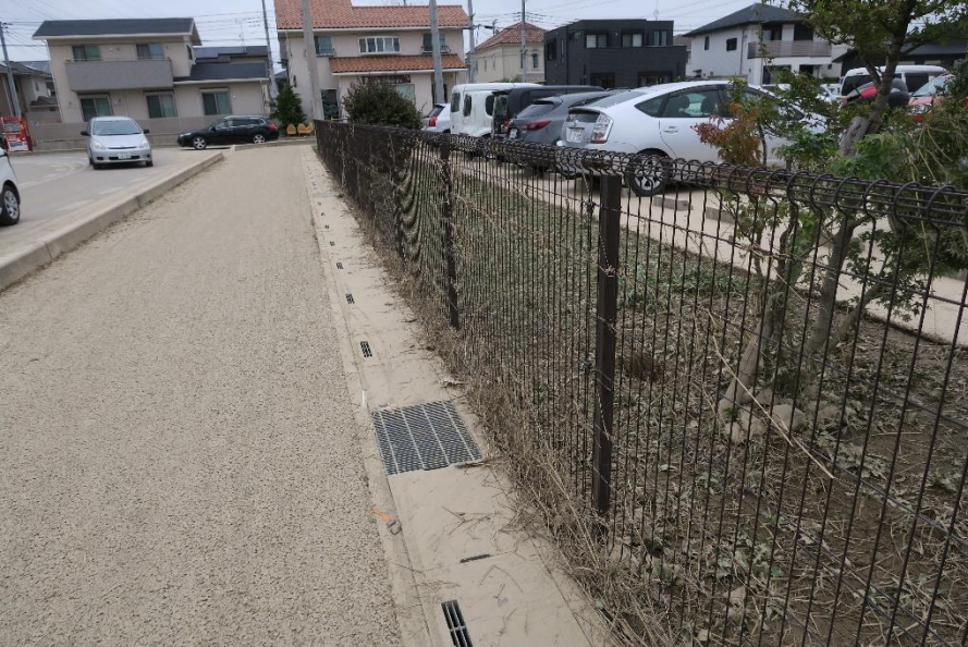
地点⑮(10月14日撮影) 盛土造成地大型商業施設東側(東松山市あずま町)。
