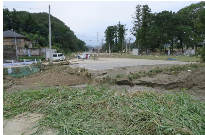
地点②(10月14日撮影) くらかけ清流の郷付近、台地(左側)と堤防(右側)の狭窄部(旧河道)を都幾川からの洪水流が流下したことを示す痕跡が残存していた。
