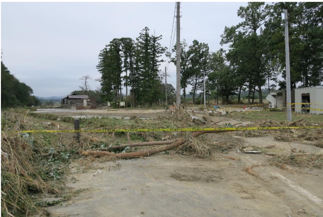
地点①(10月14日撮影) くらかけ清流の郷付近には堤防が整備されていない区間があり、都幾川からの洪水流が流れ込んで多量の流木や土砂が残存していた。
