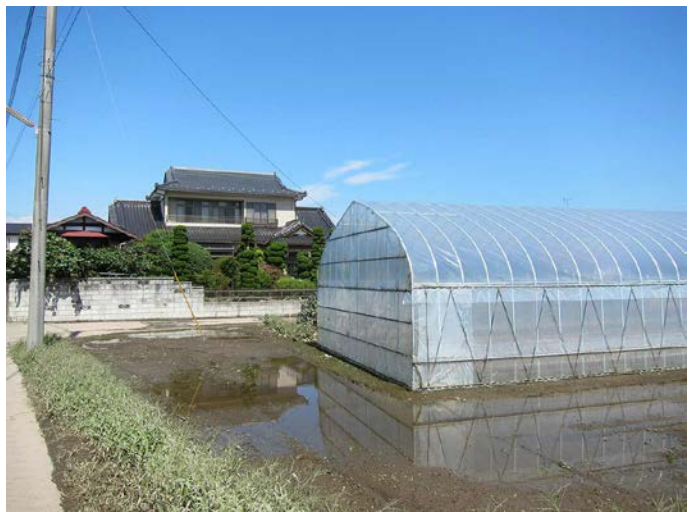
4 38.5544820N, 140.9403690E 付近 12:07 頃 氾濫平野 北方向を撮影。温室のビニルに浸水の跡。 奥のお宅は盛土上で浸水を免れた様子。 この北側の集落の住宅は, 少なくともひどい 浸水を免れている様子
