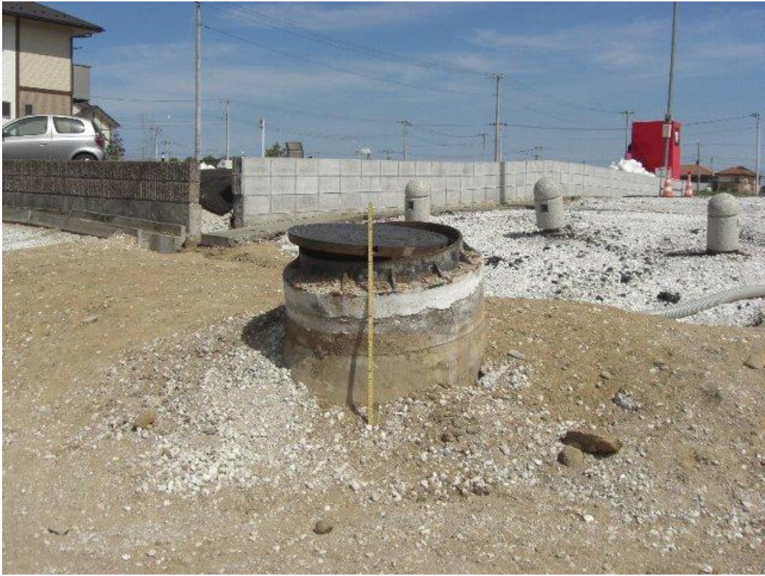
写真9 抜け上がったマンホール（平泉地区）
