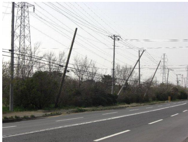
写真 14 電柱の傾斜（図 6：写真ポイント 4）
