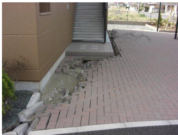
写真12 知手九丁目付近における構造物の沈下
