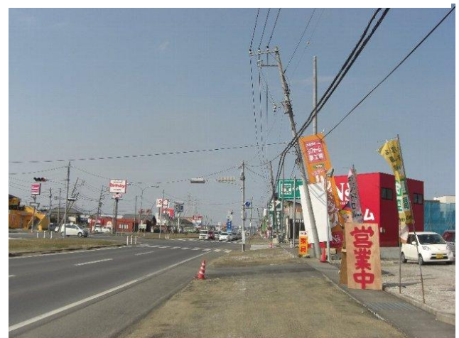
写真8 傾斜した電柱・看板（堀割・平泉地区）
