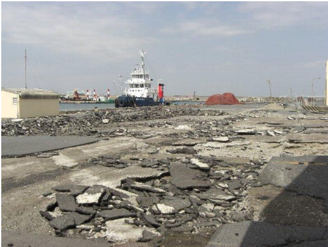
写真 23 津波によって剥がされたアスファルト舗装（波崎港）
