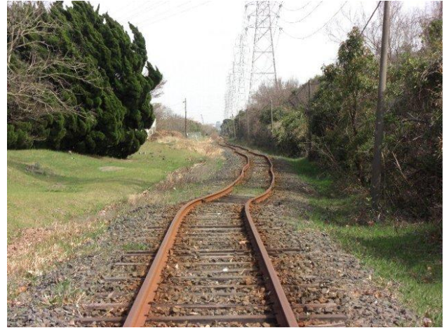
写真 18 液状化現象によって歪んだ線路 (図 6 : 写真ポイント 1)
