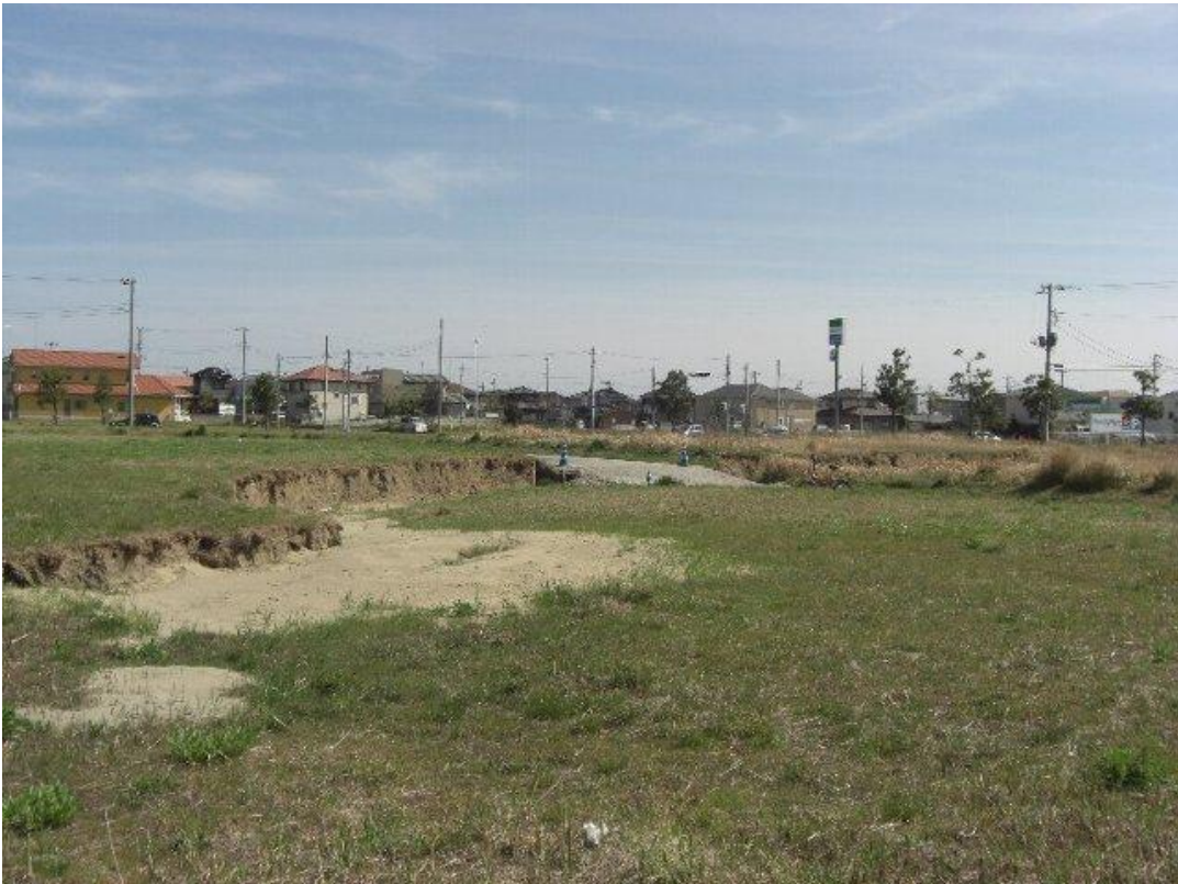
写真10 地盤沈下による小崖と噴砂（平泉地区） 比高0.4～1.0mの小崖が、80m程続いている。
