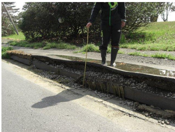
写真 13 道路の地盤沈下による歩道のめくれ上がり（図 6：写真ポイント 2）。
