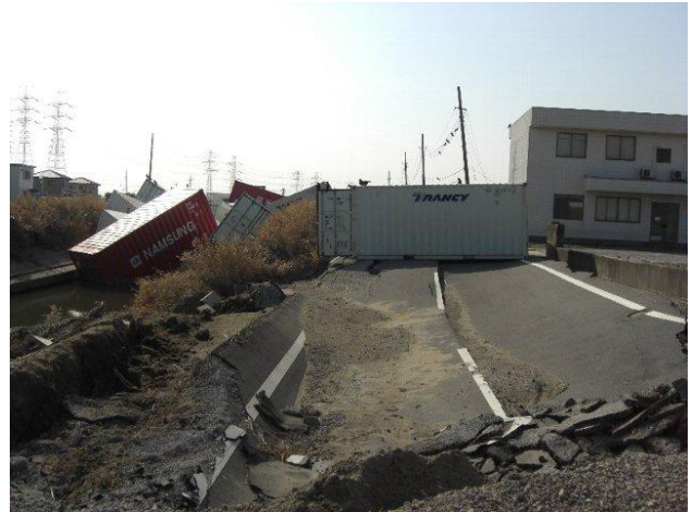
写真2 津波によって流されたコンテナと陥没した道路（長須地区）
