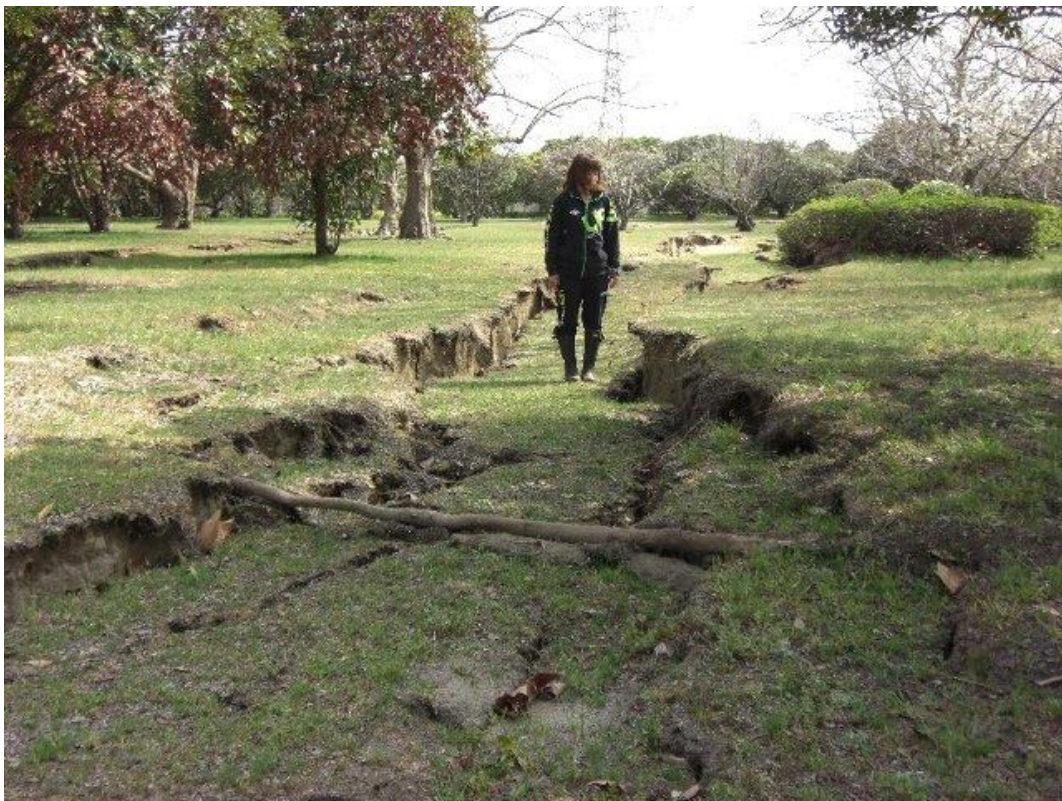
写真 16 神之池周辺における芝地の陥没（図 6：写真ポイント 1） 野球場周辺の広範囲で陥没が認められる。
