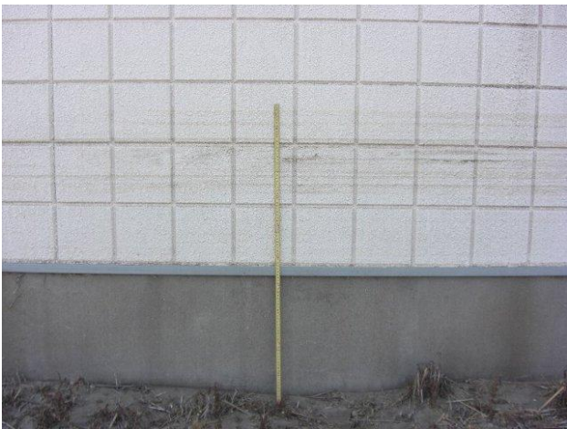
写真3 津波高の痕跡（ポイント4：1.0 m）
