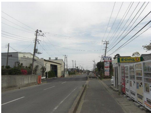
写真11 知手九丁目付近における電柱の傾斜
