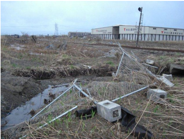
写真1 津波によってなぎ倒されたフェンス（長須地区）
