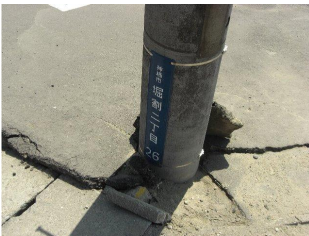
写真7 埋没した電柱（堀割地区）
