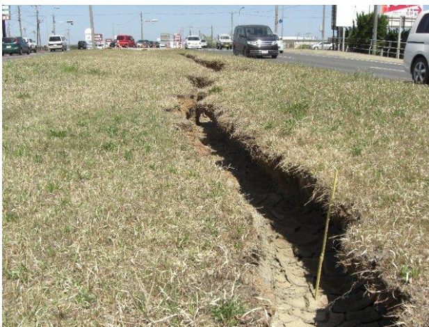
写真5 中央分離帯の亀裂（堀割地区：国道124号線）
