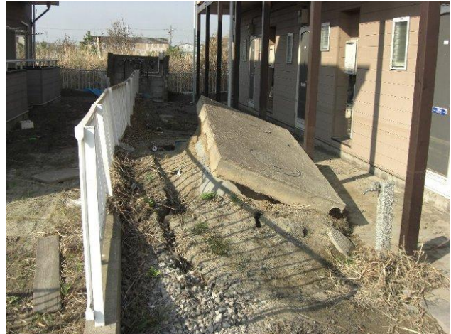
写真4 液状化現象によるマンホールの抜け上がり（長須地区）
