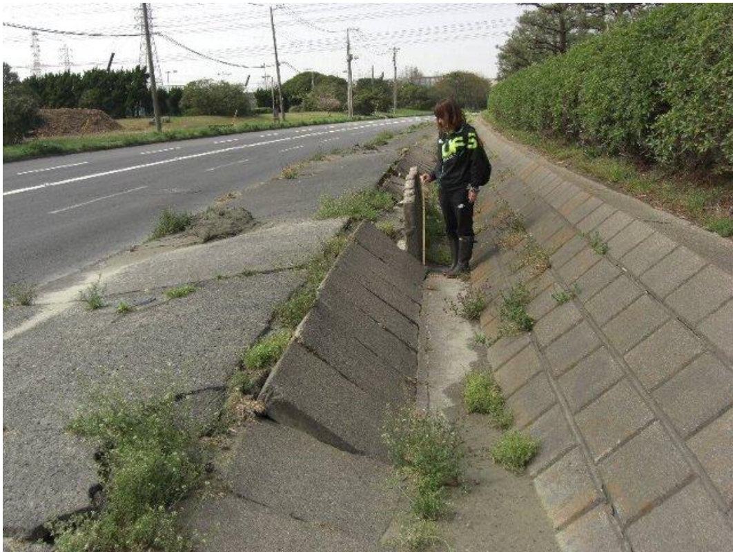
写真 15 歩道の傾斜と側溝蓋の持ちあがり（図 6：写真ポイント 3）
