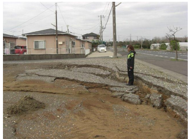
写真 20 地表面の陥没 (西須田)
