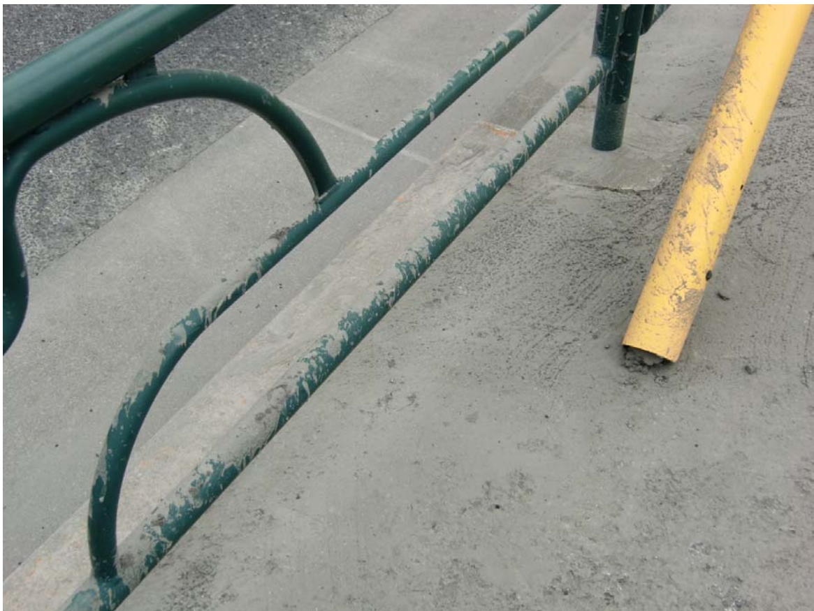
写真 5b 同上地点. 噴砂の付着が認められる.
