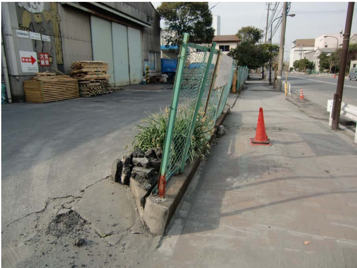
写真 11 江東区新木場 1 丁目付近. この付近の砂は除去されているが、フェンスは傾いたまま.
