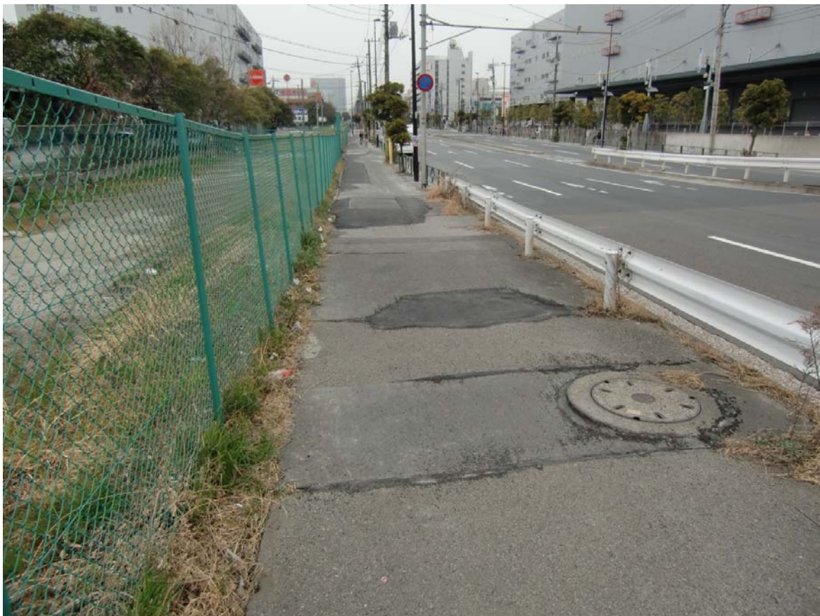
写真 6b 同上地点. 歩道は既に補修されていた.
