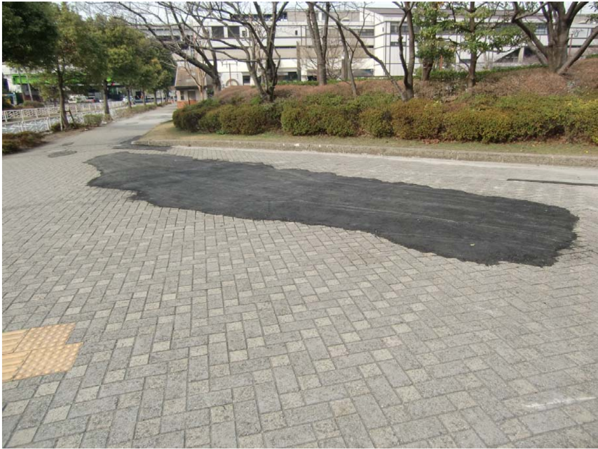
写真7 新木場駅付近. あちこちに写真のような補修跡を認めることができる.
