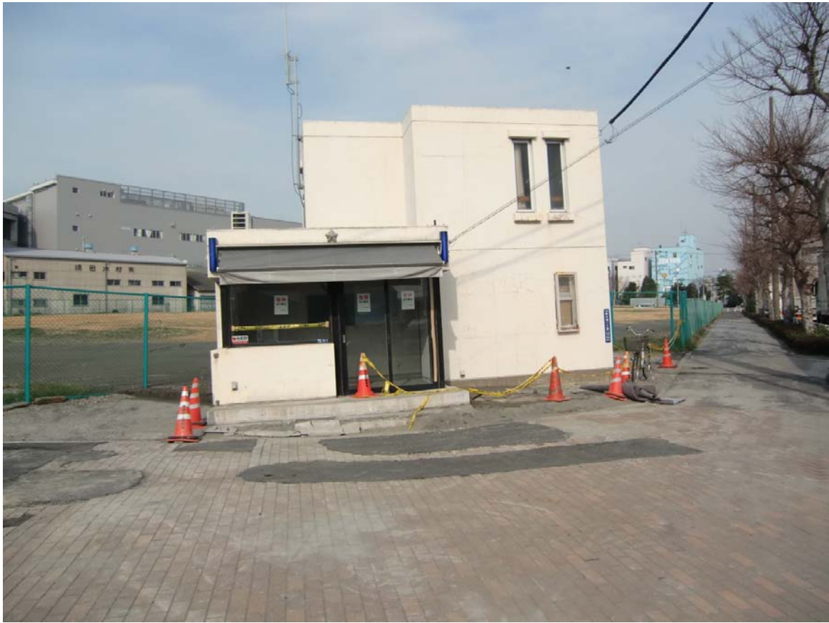
写真 12 江東区新木場 3 丁目. 交番が傾き, 立ち入り禁止となっている.
