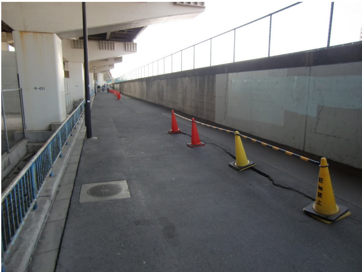
写真 4a 墨田区堤通付近. 左岸. 首都高向島ランプの高架下.
