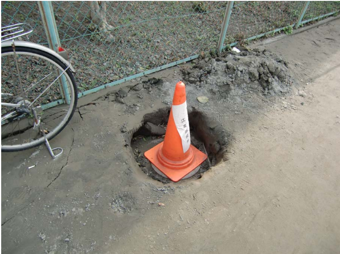
写真 9a 江東区新木場 1 丁目付近. 厚さ 20~30cm の堆砂.
