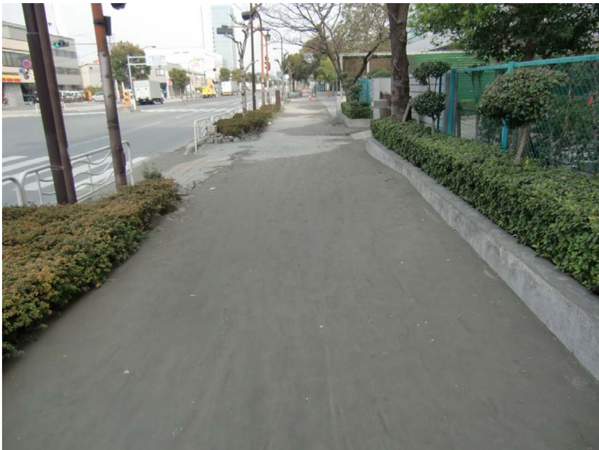
写真8 江東区新木場1丁目付近. 駅南のバス通りに沿う歩道は依然として砂に覆われている.
