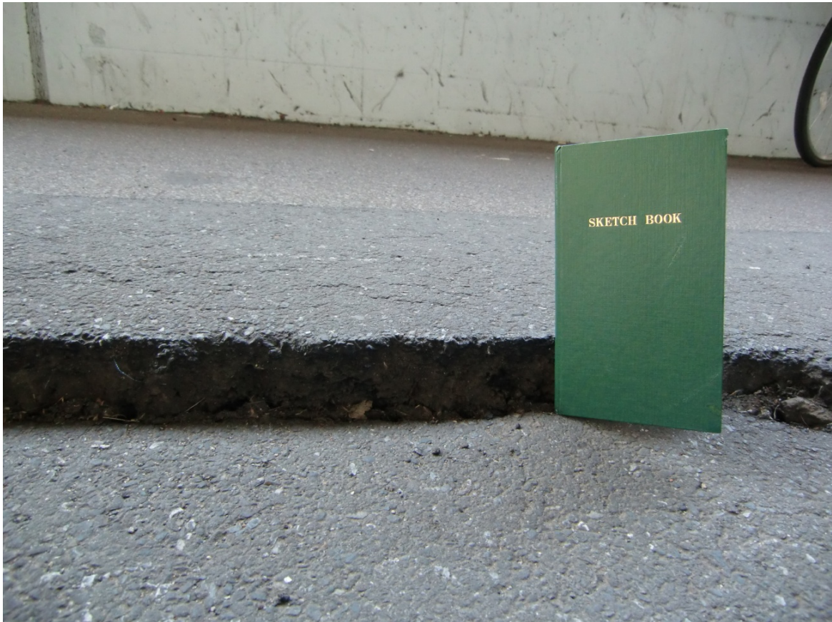
写真 4b 同上地点. 段差は最大で 5cm 程度.
