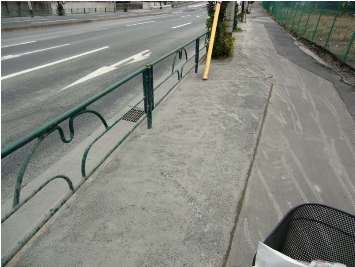
写真 5a 江東区新砂 1 丁目付近. 付近の交通量は多く, 砂は除去されていた.
