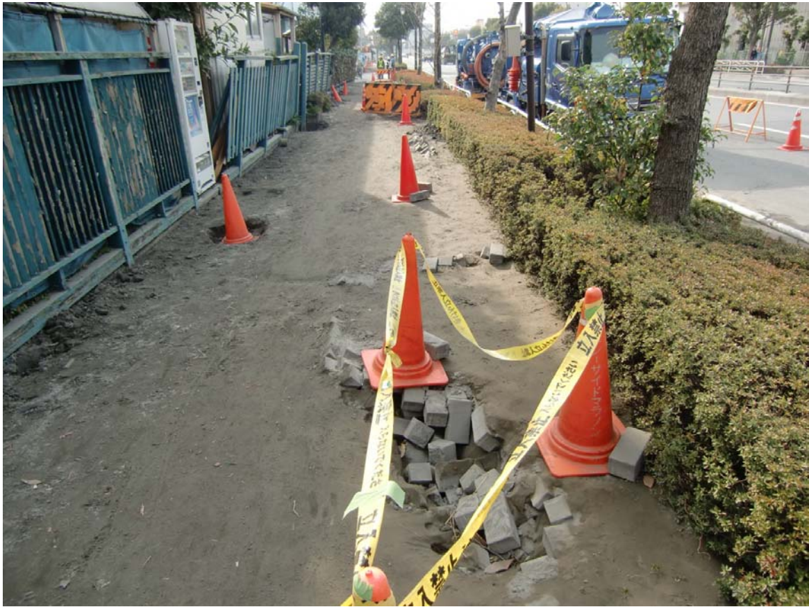
写真 10 江東区新木場 1 丁目付近. 歩道のブロックがもちあがっている.
