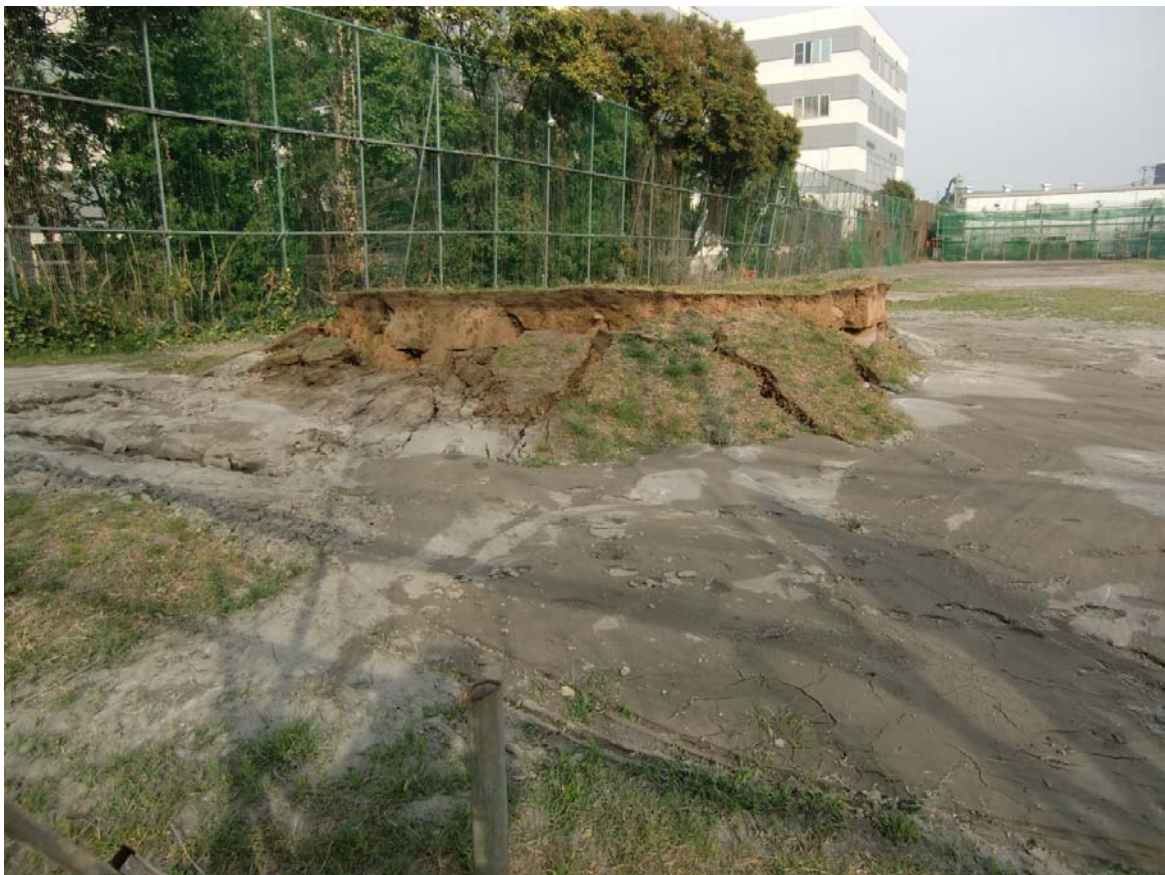
写真 13 新木場 2 丁目. 野球場の外野で液状化が顕著. 芝部分の一部が 80cm 程度持ち上がっている.
