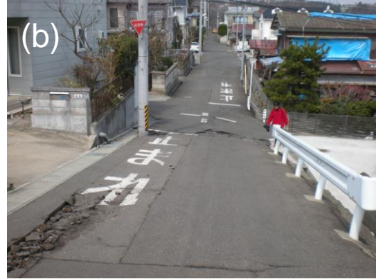
写真2 黄色の柵（写真1）の内部の公園の亀裂。伸縮計が設置され、斜面変動の監視が行われている（左）。斜面下部では圧縮により路面のアスファルトに亀甲状の亀裂及び盛り上がりが見られた（右）。
