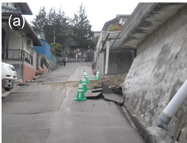
写真4 路面の圧縮性の変動。右側のカーポートの手前、三角コーンの立っている道路ではアスファルトが剥がされ片づけられていた（a）。カーポートから見た路面の変動。平らなカーポート床面よりも向こうの道路が盛り上がっているように見える（b）。
