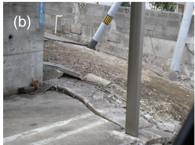
写真4 路面の圧縮性の変動。右側のカーポートの手前、三角コーンの立っている道路ではアスファルトが剥がされ片づけられていた（a）。カーポートから見た路面の変動。平らなカーポート床面よりも向こうの道路が盛り上がっているように見える（b）。
