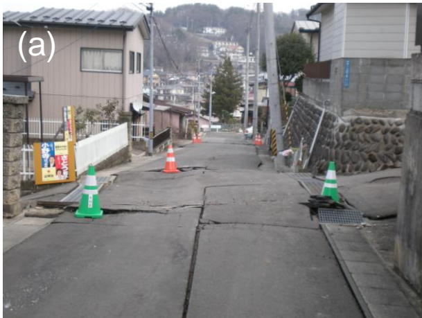
写真5 側溝は破壊されていないが、路面の右側が圧縮性的の変動を受け、路面の左側は沈下により路面の中央部が開口しているようである (a)。(a)の交差点を左に入った路面の斜面下を臨む。圧縮性の路面の短縮が見られた (b)。
