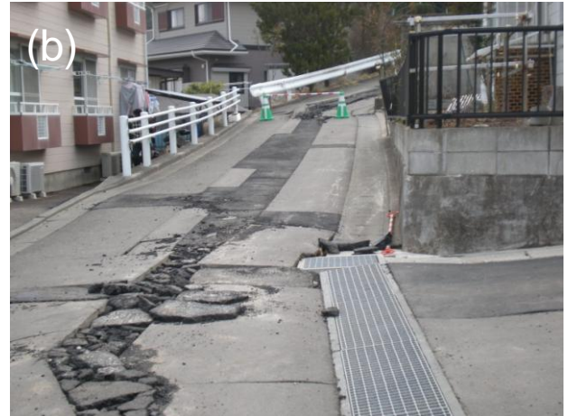
写真6 ブロック塀の道路側への倒れ込みと三角コーンが立っている周辺の路面の圧縮性の破壊。側溝には特に変動は見られない (a)。三角コーンの向こう側の路面の状況。右側の路面が見かけ上、右から左にやや乗り上げているように見える。路面の中央はアスファルトが切られて補修されていた (b)。
