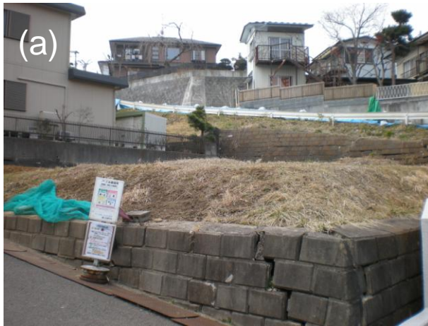
写真3 土塊のはらみ出しに伴う擁壁の損壊（a）と前面の道路における圧縮性の路面盛り上がり（b）。左側の門柱も道路側に傾いている。（a）の擁壁は（b）の道路の左側に面した家の裏側に相当する。
