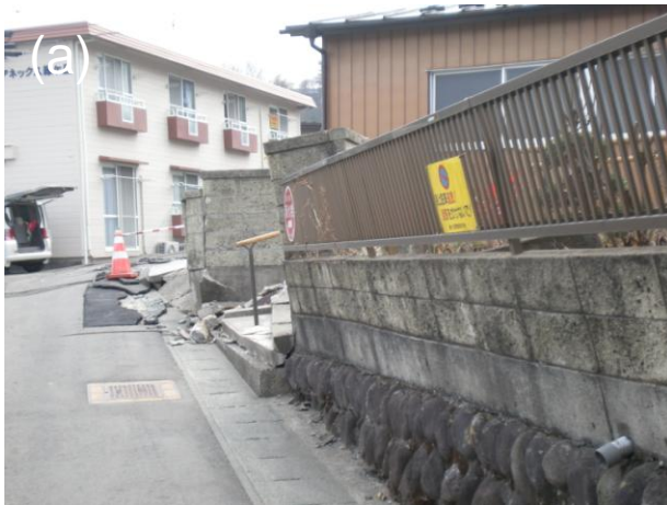
写真6 ブロック塀の道路側への倒れ込みと三角コーンが立っている周辺の路面の圧縮性の破壊。側溝には特に変動は見られない (a)。三角コーンの向こう側の路面の状況。右側の路面が見かけ上、右から左にやや乗り上げているように見える。路面の中央はアスファルトが切られて補修されていた (b)。
