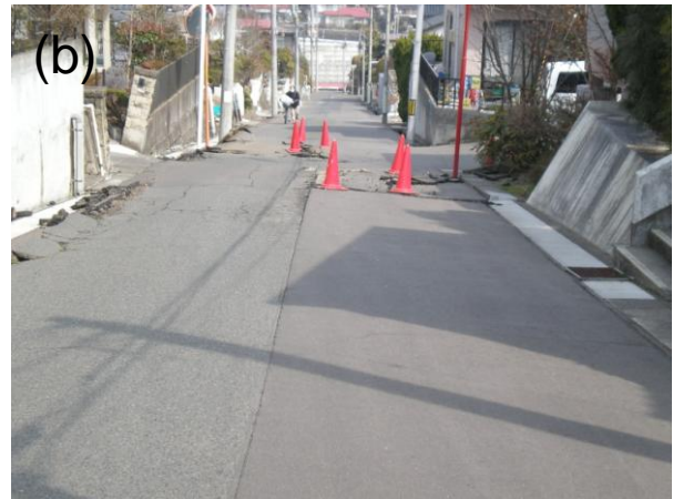
写真3 土塊のはらみ出しに伴う擁壁の損壊（a）と前面の道路における圧縮性の路面盛り上がり（b）。左側の門柱も道路側に傾いている。（a）の擁壁は（b）の道路の左側に面した家の裏側に相当する。
