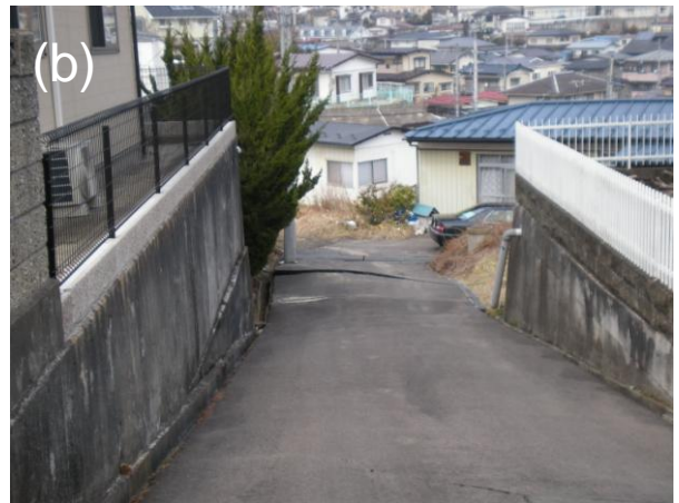
写真5 側溝は破壊されていないが、路面の右側が圧縮性的の変動を受け、路面の左側は沈下により路面の中央部が開口しているようである (a)。(a)の交差点を左に入った路面の斜面下を臨む。圧縮性の路面の短縮が見られた (b)。
