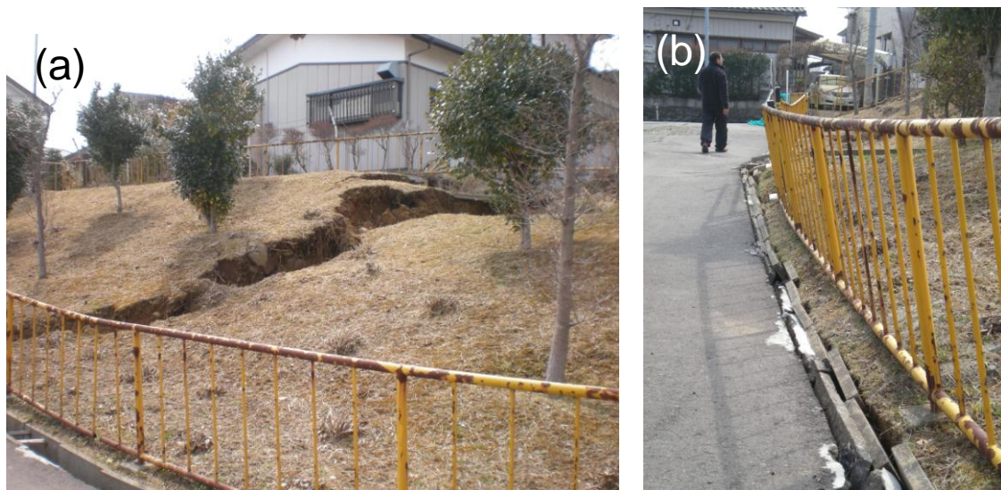
写真 1 頂部付近の標高 90m 付近における変動の状況 (a). 斜面上部からの圧縮により側溝が短縮している (b).
