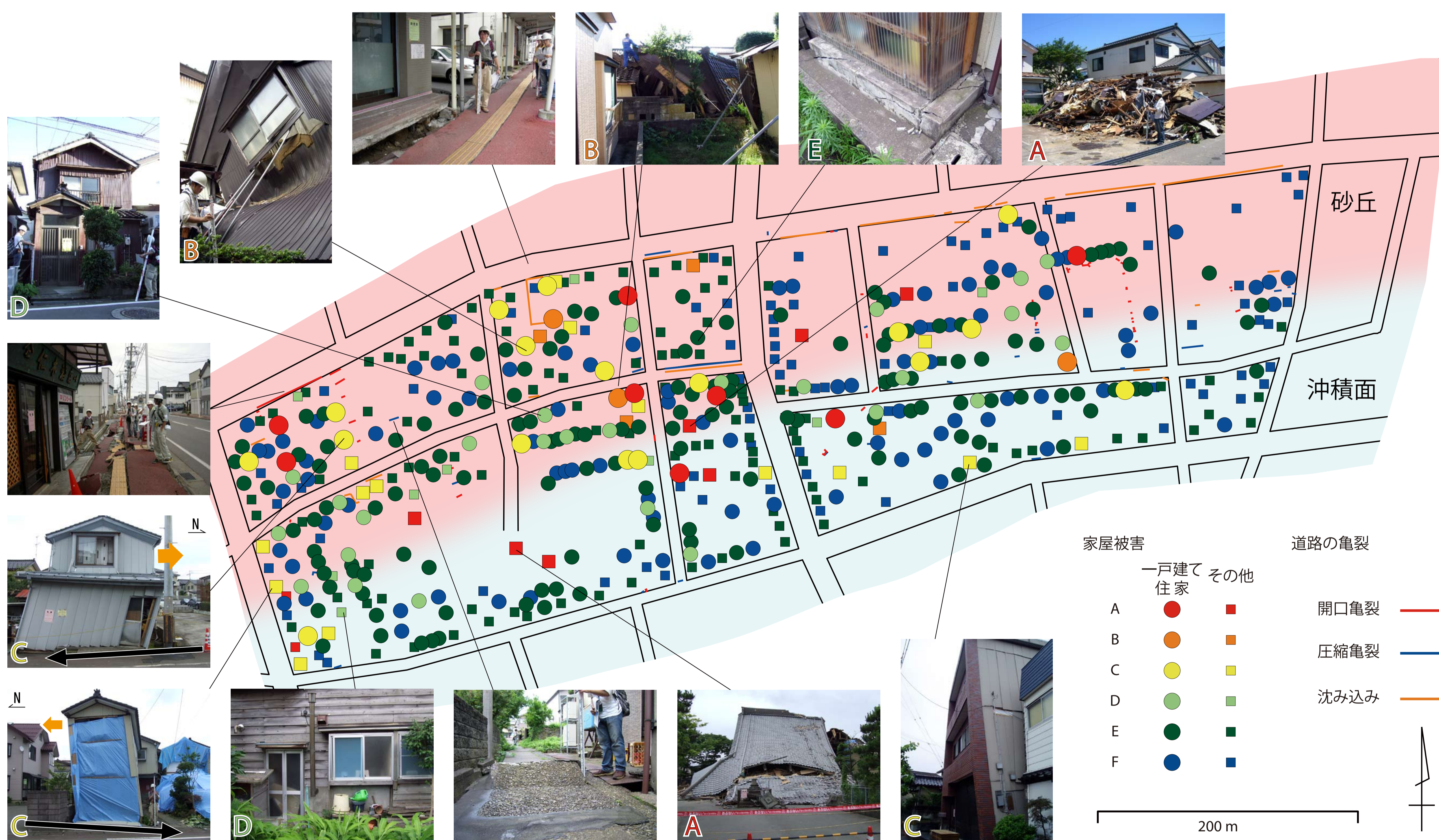
図5 調査範囲における建物被害
