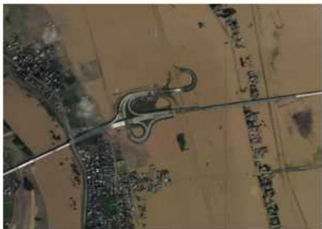
堤防決壊による洪水
