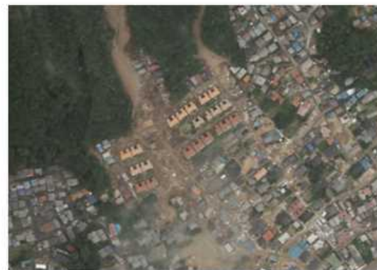
土石流による被害
