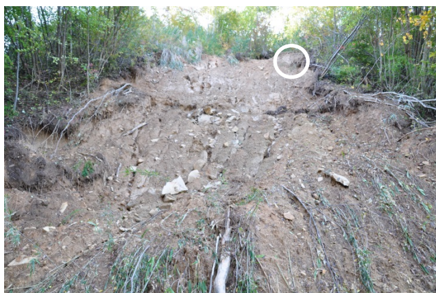
写真 17 早稲田の斜面崩壊
