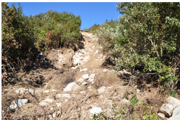
写真7 松（段田原峠の西）の斜面崩壊
