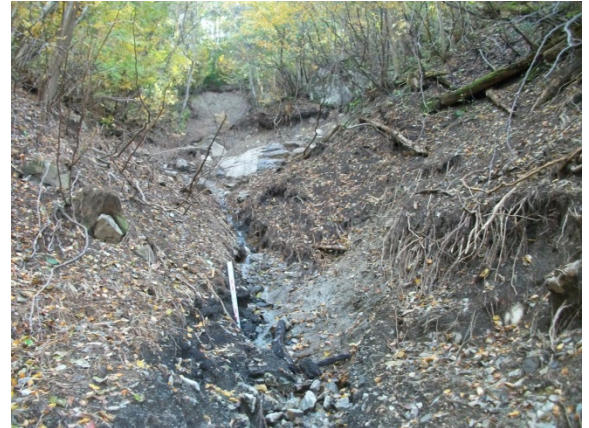
写真 14 写真 15 の崩壊源頭部
