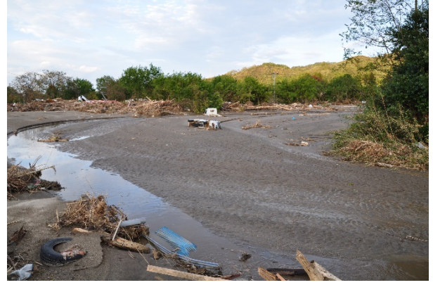
写真 12 五福谷川下流の土砂堆積
