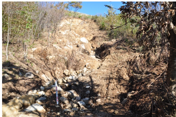
写真8 写真7の崩壊源頭部
