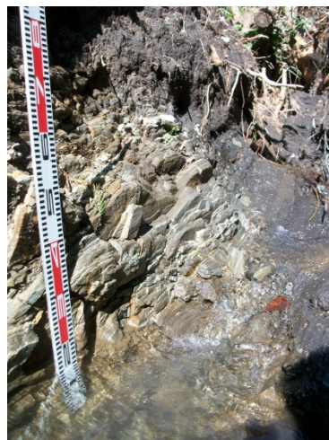
写真 16 崩壊基部の泥質片岩
