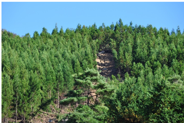
写真6 写真5の崩壊源頭部
