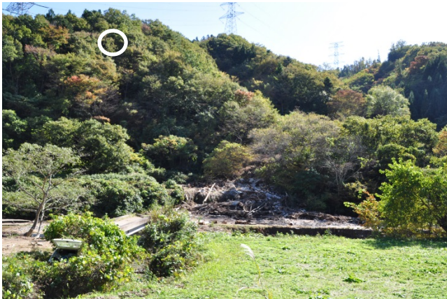
写真 13 川下の土石流の堆積域
