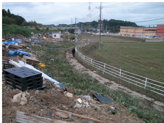
写真 13 ホームセンター付近の浸水痕
