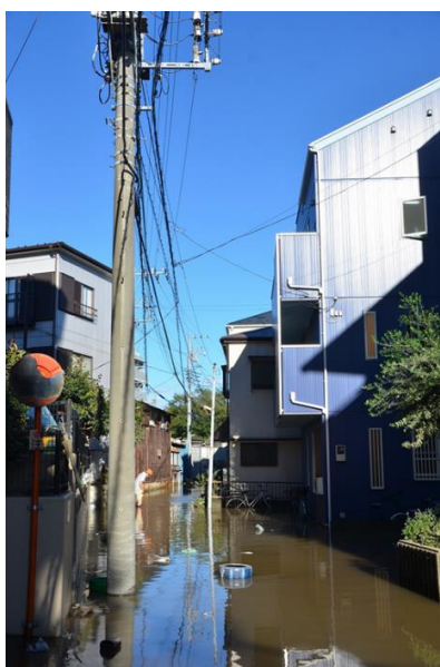
写真4 マンション背後の浸水
