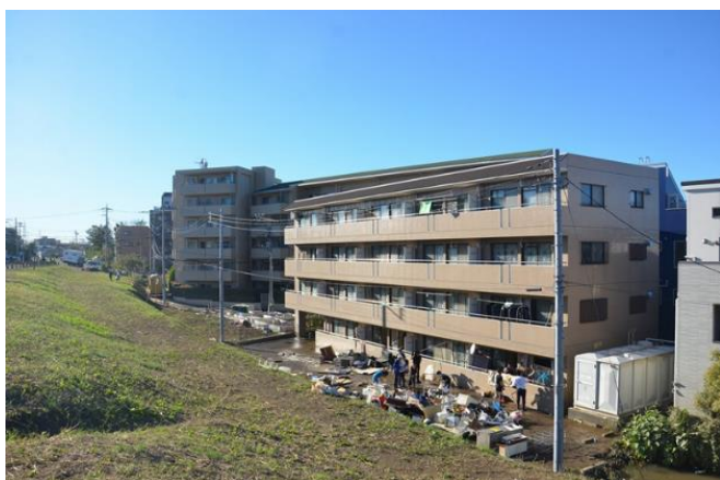
写真3 浸水したマンション
