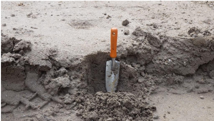
写真 1-5 末端部での噴砂の堆積状況（移植ゴテの長さは約 20 cm）
