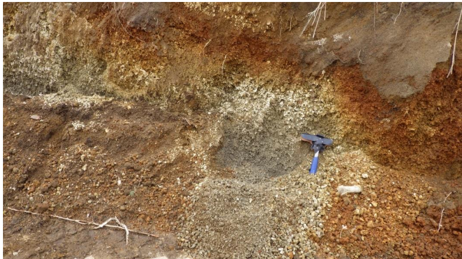
写真 2-3 崩落した土砂ブロックの断面
