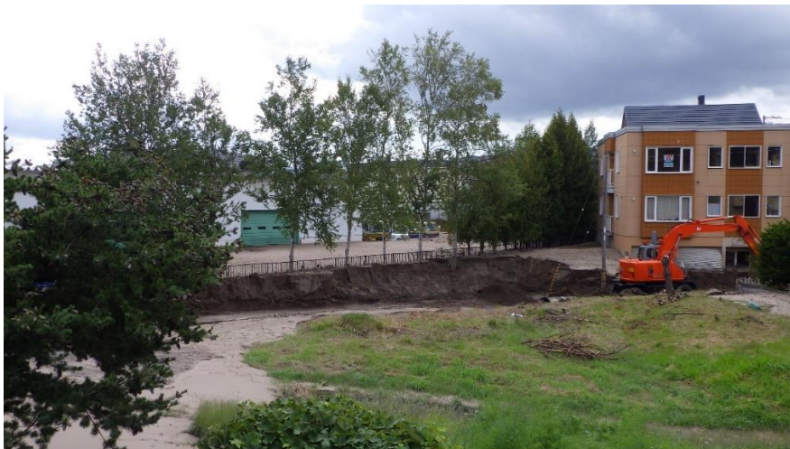
写真 1-3 噴砂が 1m 程度の厚さで堆積している
