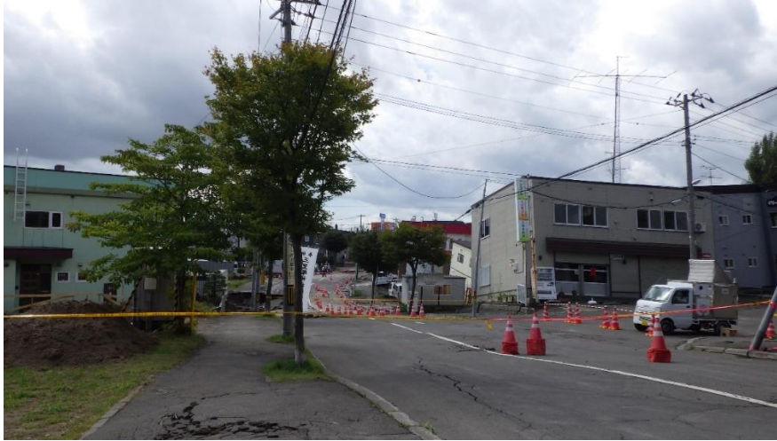
写真 1-1 傾いた看板のある建物から向こう側が左右方向に帯状に沈下している
