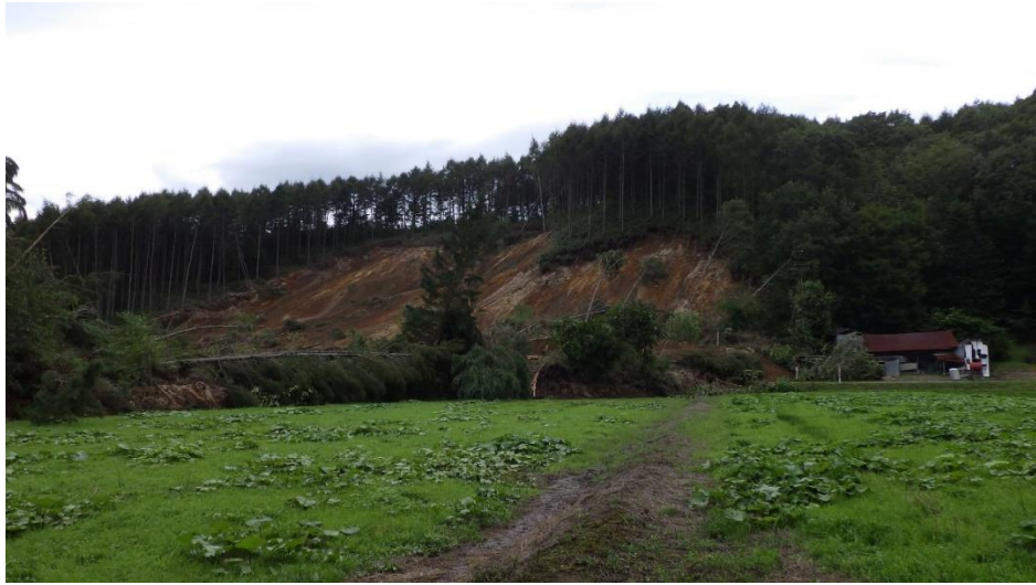
写真 2-1 観察した斜面の全景
