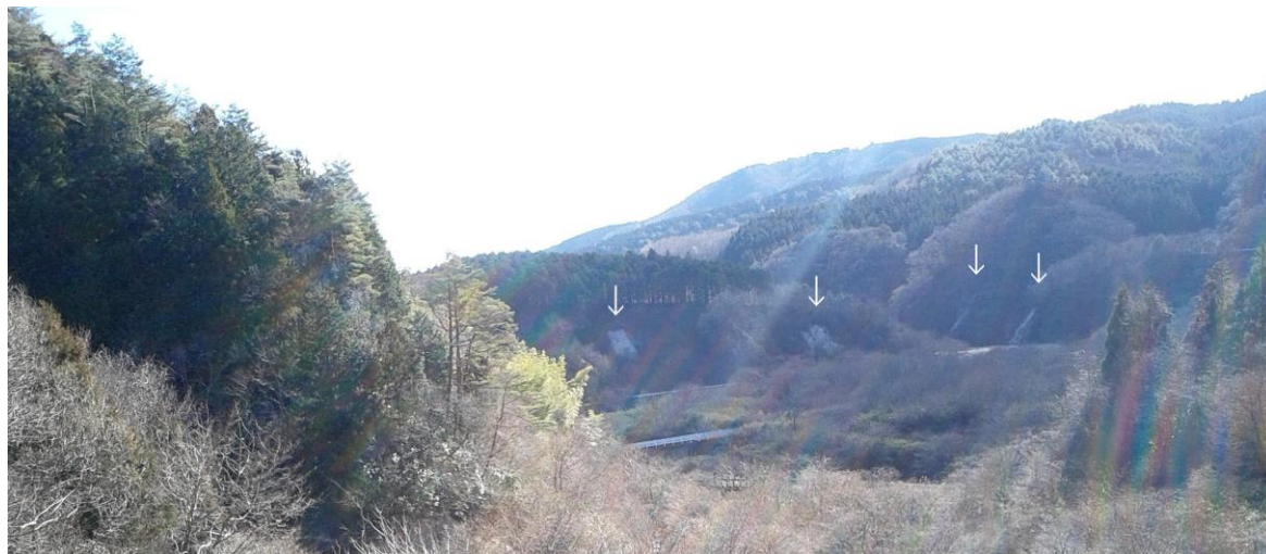
図2 本地震による表層崩壊(場所は図1のC地点を参照)
