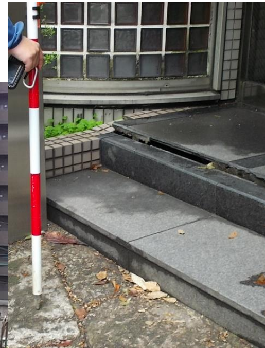
隣接のコンクリート建物
