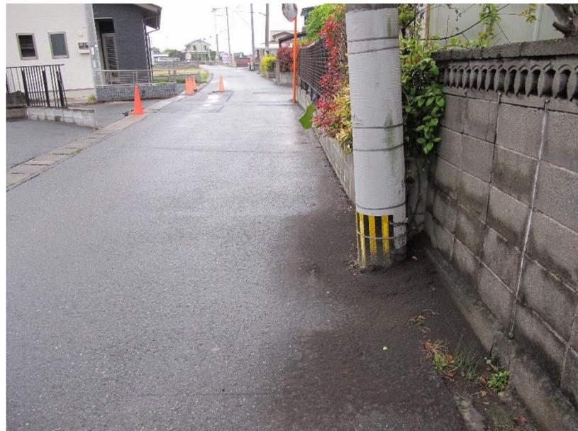
電柱周囲の噴砂と電柱の沈下・傾斜(中原町)
