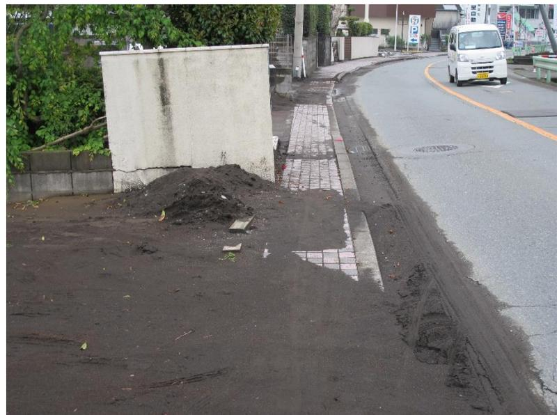
噴砂の堆積、塀の不同沈下、路面変形・損傷(近見)
