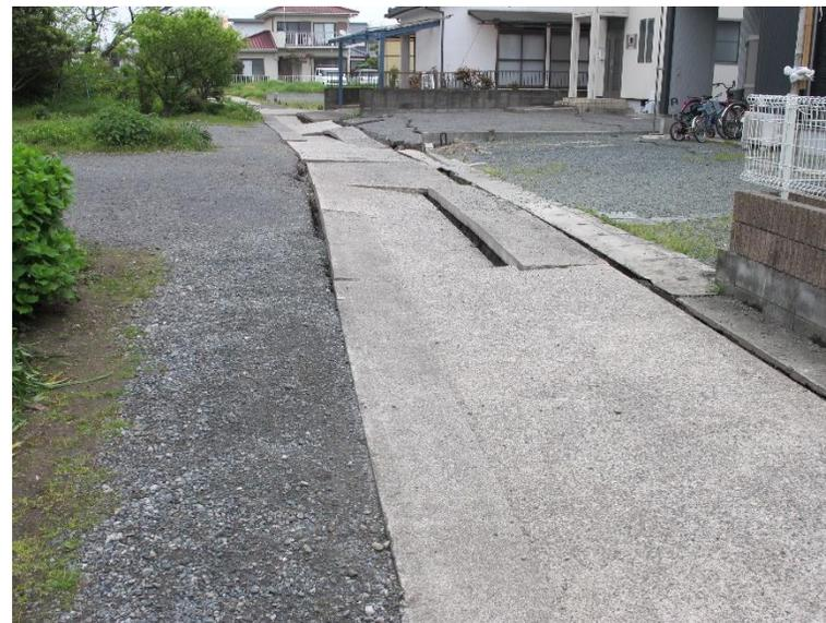
道路・宅地地盤の変形、路面の変形・損傷、
