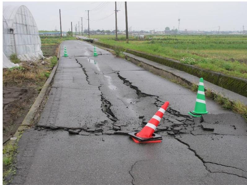
路面陥没(管渠埋戻し土の液状化に起因?)
