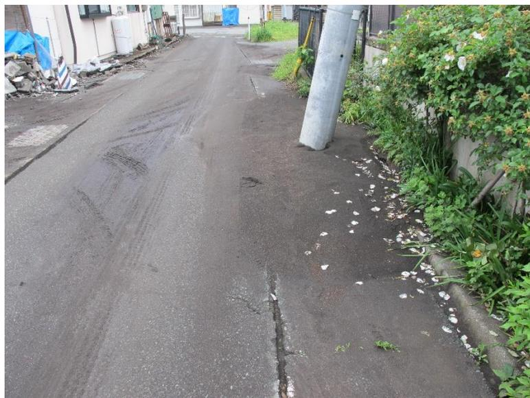
電柱周囲の噴砂、電柱の傾斜、路面変形・損傷(近見)
