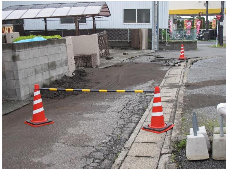
宅地地盤、ブロック塀の不同沈下、マンホールの浮き上がり、路面の変形・損傷(近見)
