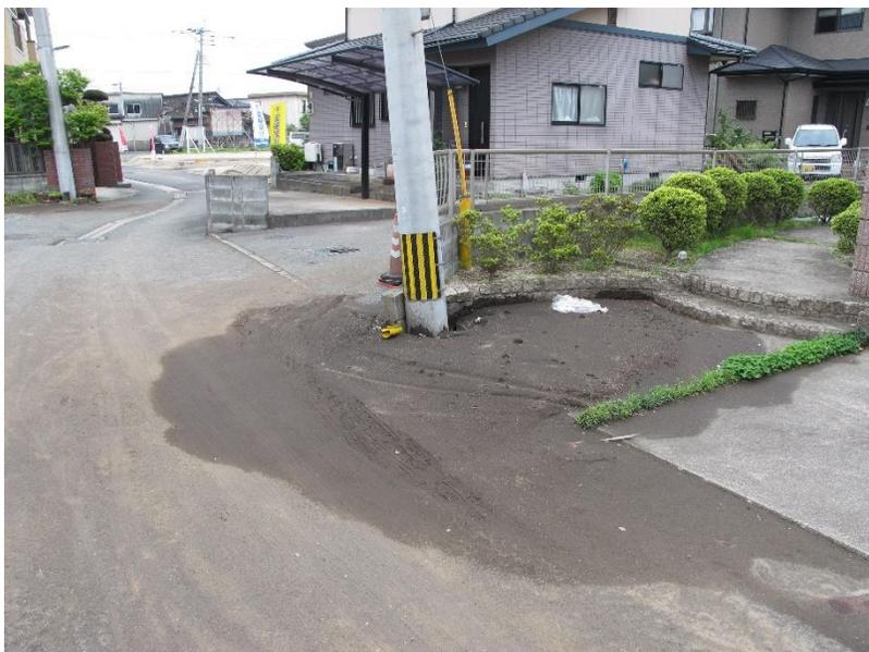
電柱周囲の噴砂と電柱の傾斜(土河原町)
