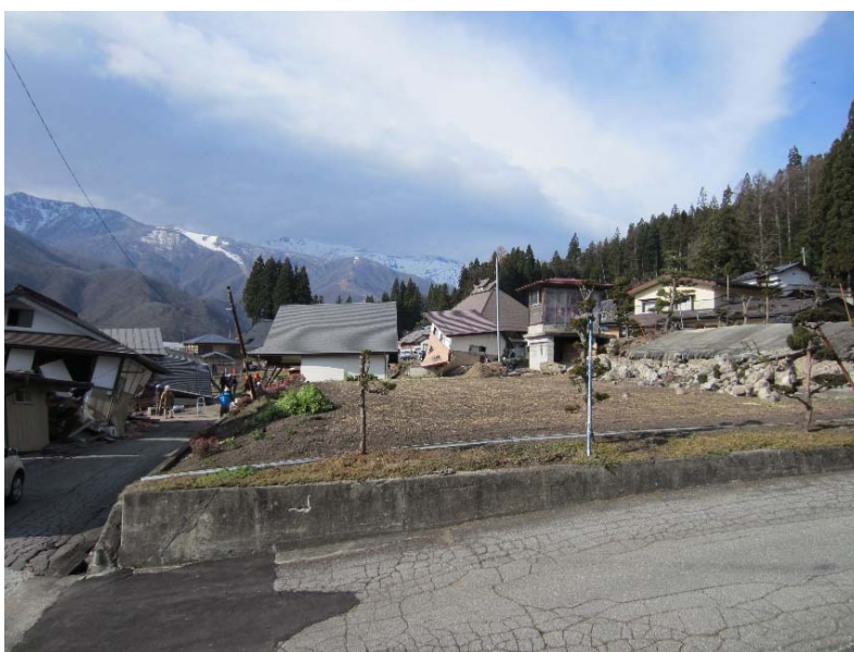
写真 2 : 堀之内地区の被害 (堀之内地区から写真 1 地点方向を望む。)
