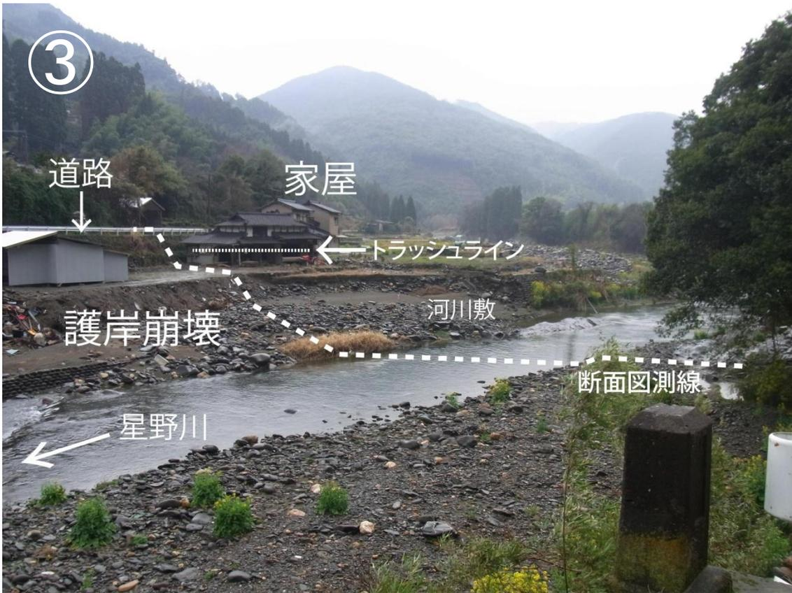
③: 家屋土塀に明瞭なトラッシュラインが残されており、それは水面より6.2mの高さであった。滑走斜面側の護岸が河川侵食により崩落しており、家屋付近まで侵食が迫っている。応急処置すらいまだ行われていないため、元の生活に戻るのには難しそうだ。
