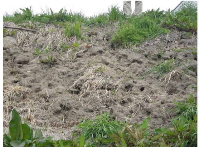
写真B-6 B-5と同地点の拡大。パイピング現象によって生じたと思われる無数の穴がある。
