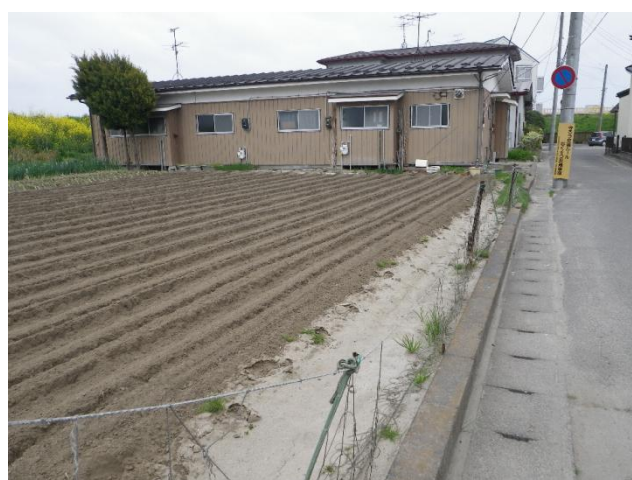
写真B-4 住宅地の畑に残る泥の痕跡。冠水が生じたことを示す。
