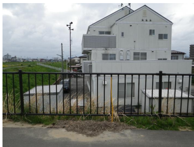
写真B-2 2河川の合流点付近にあるV字型堤防の先端部に堆積する稲わらと砂。住民への聞き取りによると、水はここから住宅地へ流れた。
