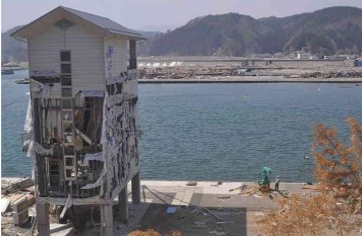
町の東端にある神社（図 1 赤丸位置）の石段での津波の痕跡（ガードレールの変形など）は、海面（4 月 13 日 11:00AM；同じく小潮の干満中間時）から高さ 15m まで認められた。また漁協の建屋も高さ 15m くらいまで破損していた。前掲の地震研の調査結果によれば田老の津波遡上高は 11.7~19.1m とされているが、田老漁港付近の海岸部の波高は 15m 前後とみられる。
