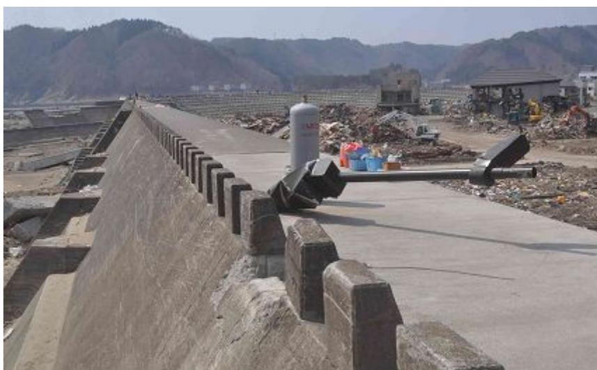
日本一とされた防潮堤は10.45mの高さを誇っていたが、簡易レーザー機器により実測したところ、堤体の高さは基部から天端（上面）まで5.5mしかなく、基部の地面から海面（4月13日10:00AM；宮古の潮位表によれば小潮の干満中間時）まで3.5mで、合計9mであった。電子基準点からの本震の上下変動は田老あたりで-0.3m（内挿値）が示されている。それを加えても、10.45mは、おそらく低潮位に近い工事基準面（北上川基準面K.P）からの高さだろう。平均的な海面からは10mの高さがなかったことになり、いずれにしても、次ページでの測定結果のような15mもの波高では、全く歯が立たなかったわけである。
