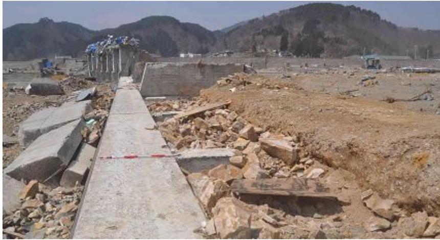
津波によって破壊された防潮堤は、長さ約 500m で、南向きの田老漁港奥部に位置する（図 1）。破壊された断面からは、外壁（海側）を厚さ 1m のコンクリートで覆い、内部に砂礫を充填した緩傾斜型という構造。写真の左側（海側）に倒壊したコンクリート外壁が残っているが、破壊された後に引き波によって海側に倒れたもの。
