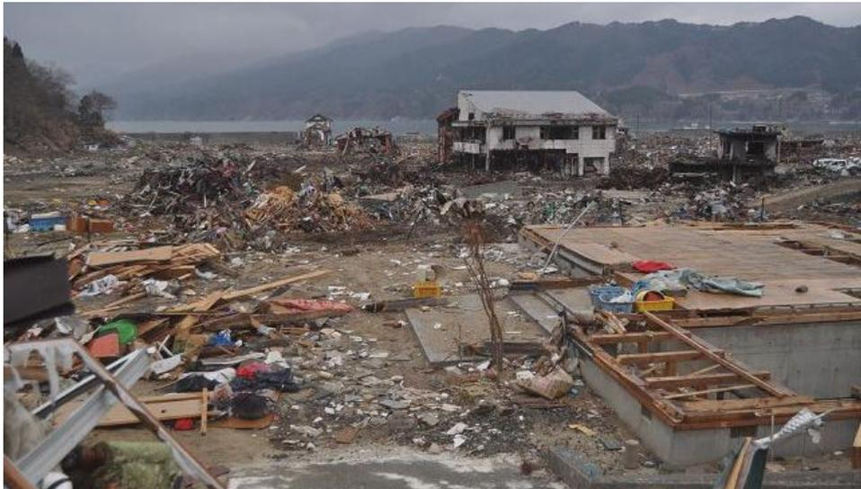
低位段丘の段丘崖付近から見た田ノ浜の被災跡。段丘崖直上の家屋は倒壊しなかったものの損傷を受けた家が多い。この段丘崖より上方の津波遡上上限位置を住民から聞き取り、そこから海面（5月2日11:00AM）までの高さの実測値は16.0mであった。
