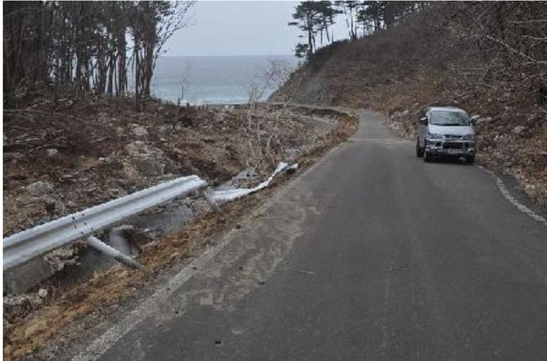
津波遡上範囲は、海岸から漣磯沢沿い水平距離452m/海面(4月11日14:00)から高さ27mまで。その間の沢の河床勾配は $3.5^{\circ}$ 前後。引き波により、倒木・流木は全て下流へ向いている。路面にも引き波による砂が残る。
