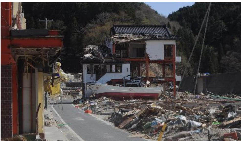
田ノ浜の防潮堤近傍の建屋の屋根瓦の変状が、海面から12.6mの高さに認められた。これは海岸部での波高を示すもの。
