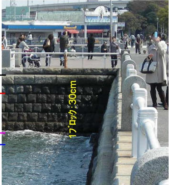
写真7 津波最大波到達時と被害調査時点の海水位
