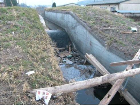
河口から 3.5km 上流まで津波が到達した。ただし到達地点と判断した場所では、側面から堤防を乗り越えて河道内に流れ込んだとみられる瓦礫・ゴミも多く、河道に関係なく津波が遡上してきた可能性もある。
