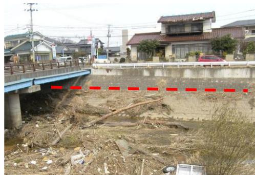
D：堤外斜面上に付着する泥・稲ワラ（赤破線部より下の部分 増田川）
