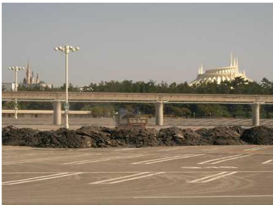
東京ディズニーランド駐車場。地震後に液状化し、水と泥砂により一面 池のような状況下であったという。TDLは、復旧を急ぎ、液状化して噴砂した砂はほぼトラックで運送済み（13日時点）。（背後はシンデレラ城やスペースマウンテン）
