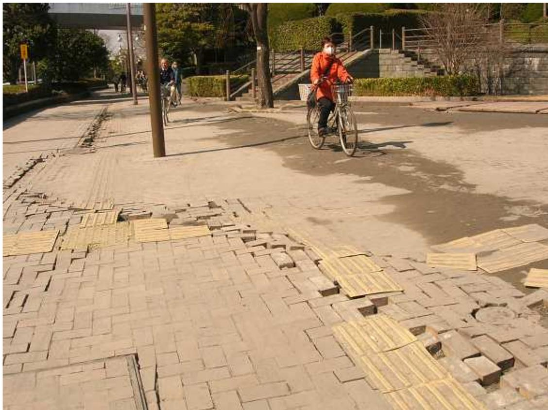
(上記3枚) 京葉線新浦安駅 駅前交差点。液状化現象で傾いた電話BOXや隆起や陥没がみられる舗道。駅前のため、砂は13日現在ある程度撤去され、液状化で損壊した舗装レンガが見えている。
