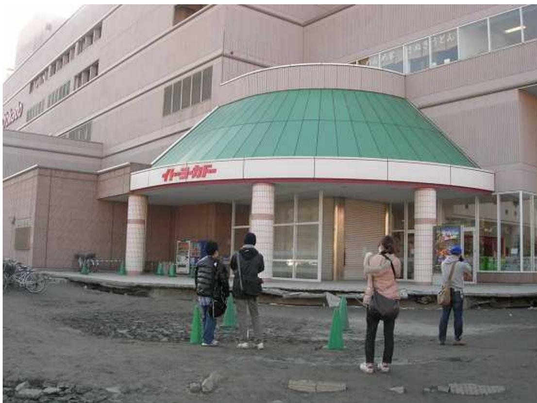
京葉線新浦安駅 大型スーパー。70cm地盤沈下
