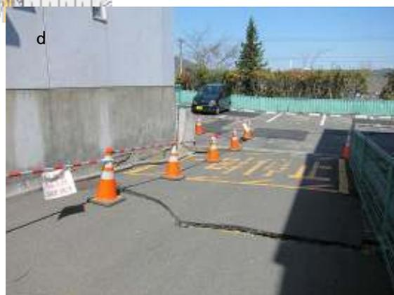
上の写真は、いずれも谷埋盛土部と推定されかつ法面直上の宅地である。dの集合住宅は建物そのものの被害は不明（ない？）だがその周囲の地盤変状が大きい。eは宅地に亀裂も認められ戸建て住宅も傾斜している。
