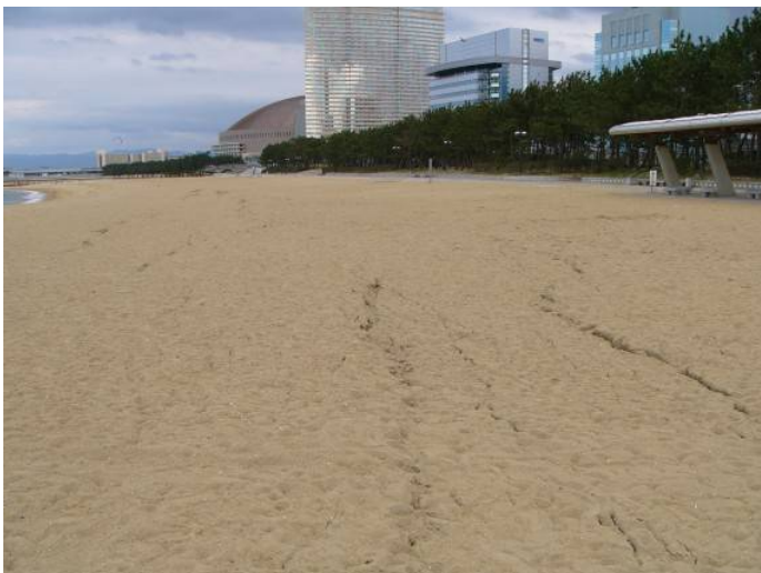
写真5 小さな地割れ (東側人工海浜、 2005年3月20日撮影)
