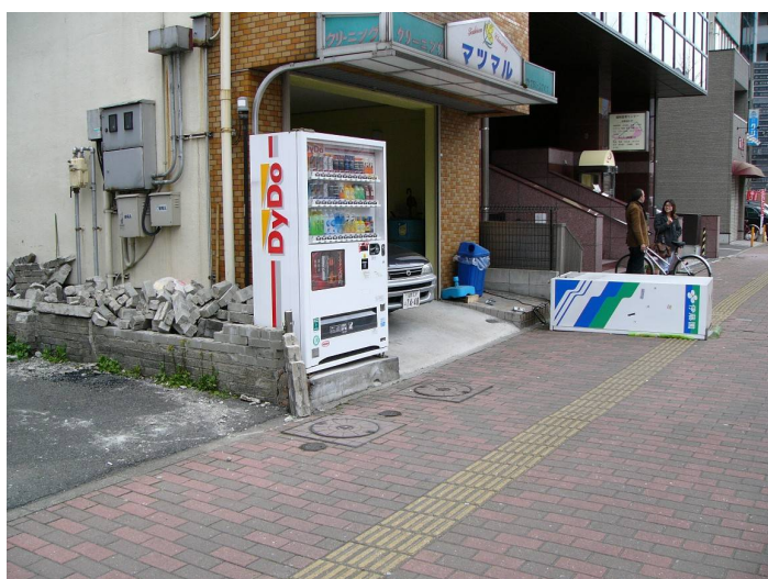
写真 2 倒壊したブロック塀と自動販売機 (2005年3月20日 後藤撮影)
