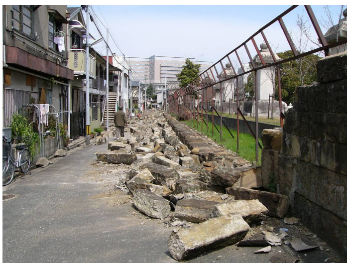
写真3 倒壊した崇福寺の石塀 (2005年3月21日 後藤撮影)
