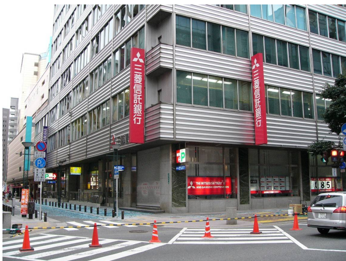
写真 1 窓ガラスが割れた福岡ビル (2005年3月20日 後藤撮影)
