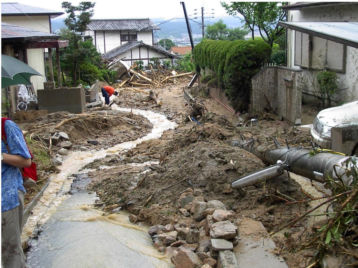
太宰府市国分の土石流は午前5時少し過ぎた頃に発生。ドンという音がした時には土石流が襲っていた。事前の山地崩壊などは雷と豪雨の音に阻まれて全く聞こえていない。避難命令等は事前にはなかった。背後の渓流には昭和61年完成の砂防ダムが3基あり、この効果で大岩や流木はある程度食い止めている。この写真の宅造地内の道路は渓流出口に直接繋がっており、住宅街の土石流対策工は全く行われていない。電柱も倒壊しており、家屋が一部破損程度の被害で済んだのは不幸中の幸いである。
